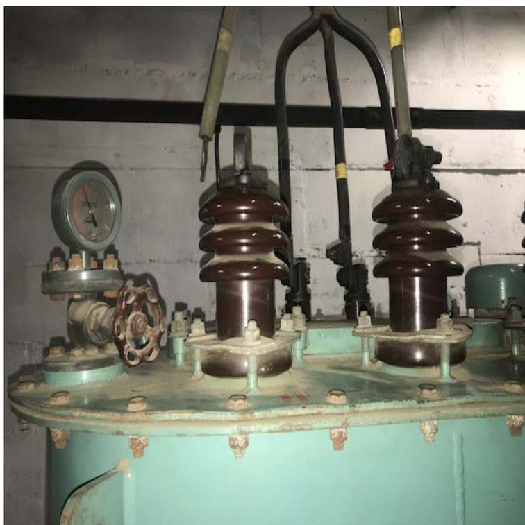
Imagem VI: Parafuso quebrado devido à degradação por corrosão
