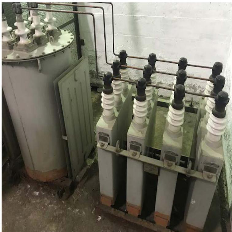
Imagem VII: Marcas de oxidação acentuada e marcas de água devido à parcial inundação.
