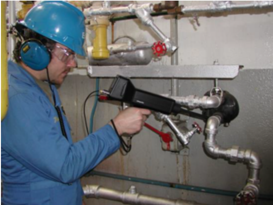
Figura 2: Inspeção de vazamentos com um detector de ultrassom Fonte: UE Systems (2014)
