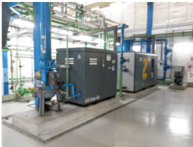
Figura 10: Compressores Fonte: O autor
