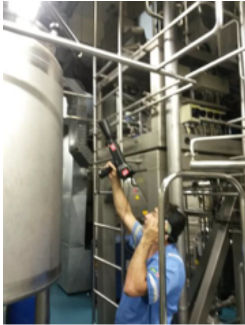
Figura 7: Detecção da região com provável vazamento Fonte: o autor
