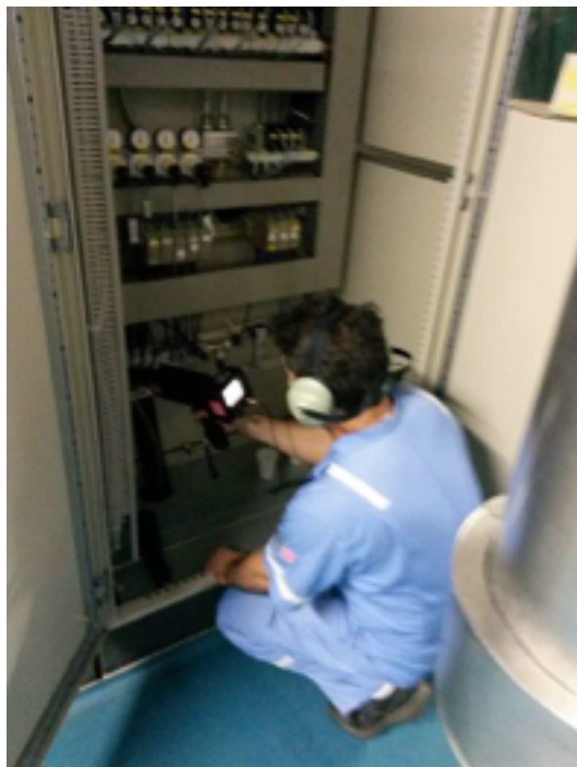
Figura VIII: Detecção de componente com provável vazamento Fonte: O autor
