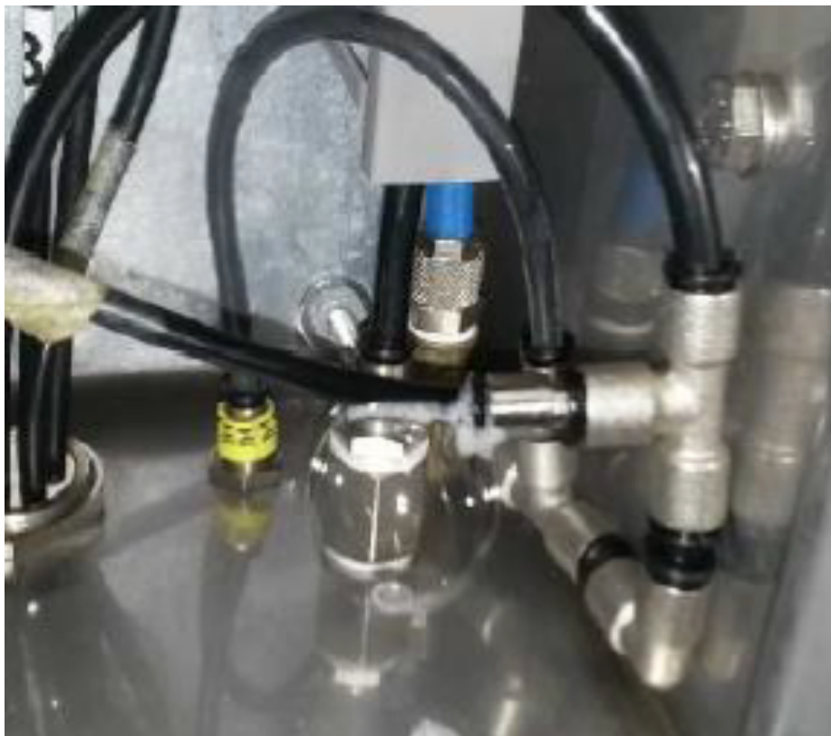
Figura 9: Identificação visual de vazamentos Fonte: O autor
