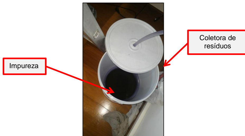
Figura 8: Balde com impurezas retiradas da evaporadora. Fonte: Autor
