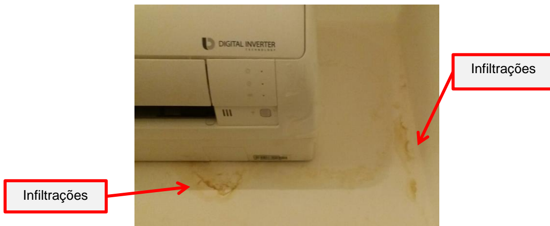
Figura 7: Infiltrações na parede devido a ausência de vedação. Fonte: Autor
