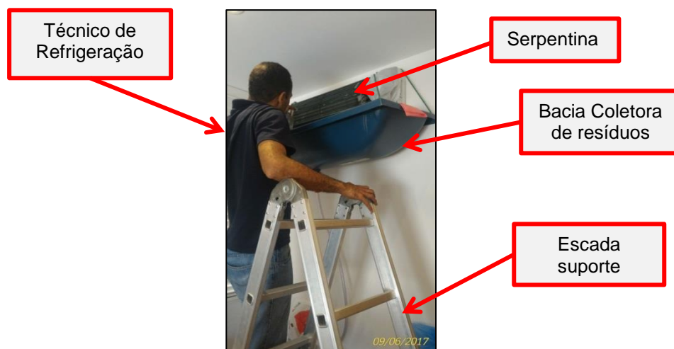
Figura 9: Limpeza da unidade evaporadora. Fonte: Autor
