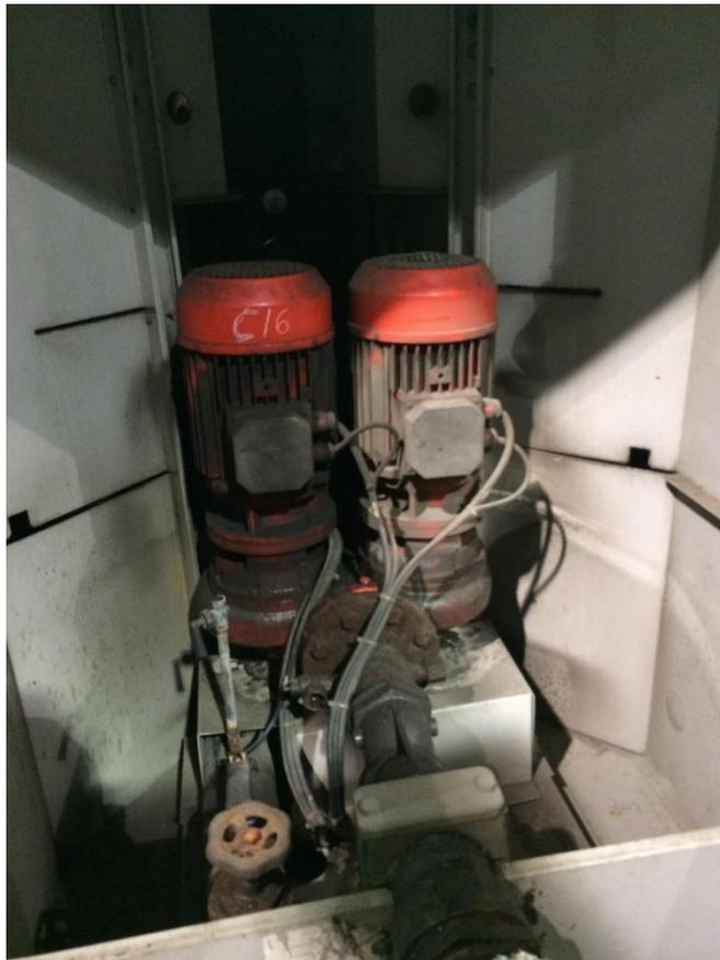
**Figura 8 - Bombas do Sistema de Circulação de Água Gelada**
