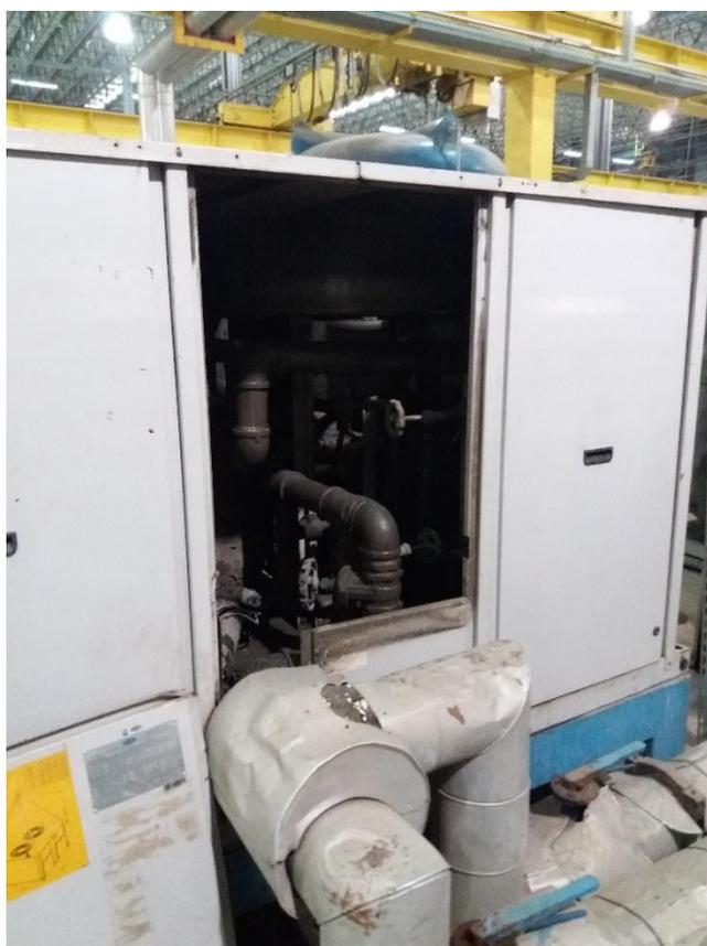
**Figura 7 - Compressores no interior do Chiller**
