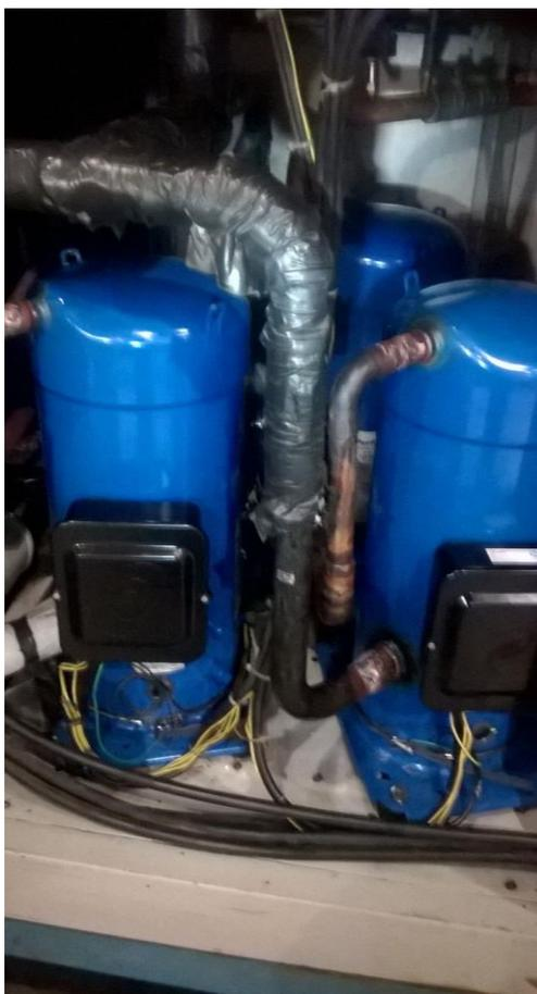
**Figura 11 - Novos Compressores instalados**
